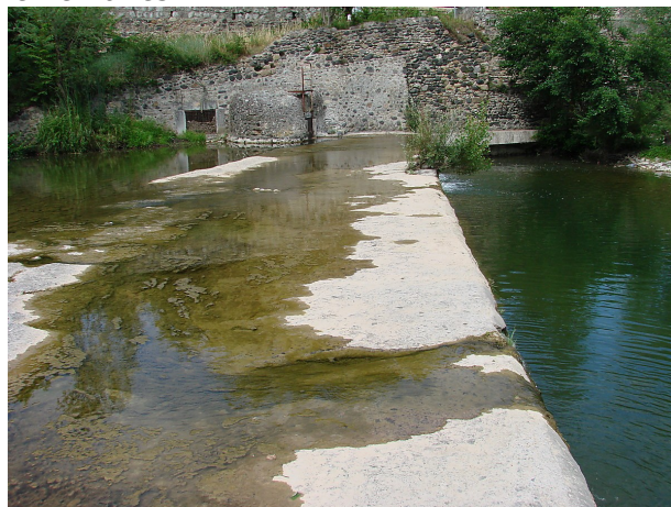
Prise d'eau du canal de l'usine Payen
