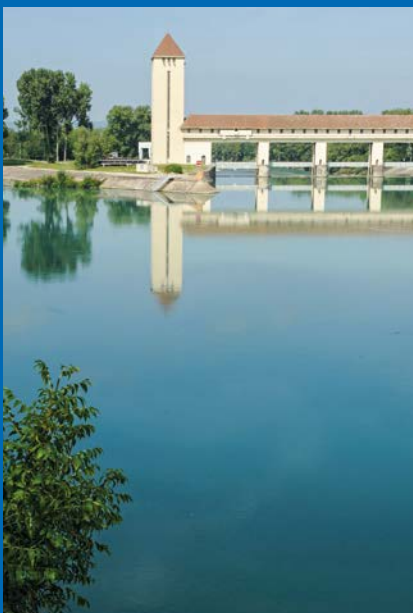
Barrage de Jons sur le canal de Miribel.
