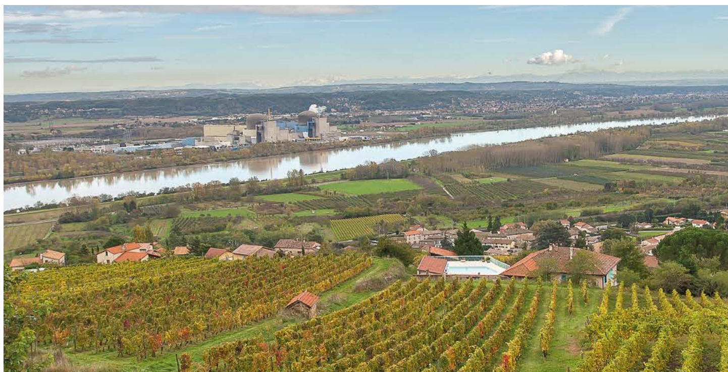
Centrale Nucléaire de Saint-Alban, vue depuis Chavanay.
