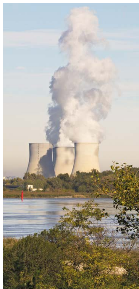
Centrale Nucléaire de Cruas-Meysses.
