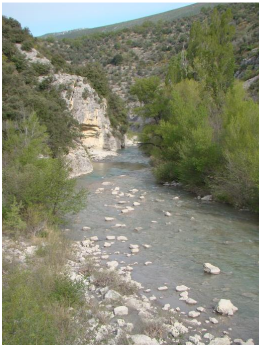
Illustration n°1 : Eygues, pont de la Tume à Saint May
