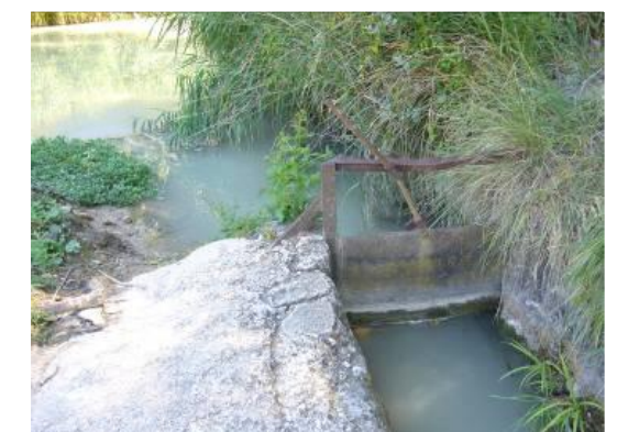
Canal d'irrigation sur le Haut-Calavon
