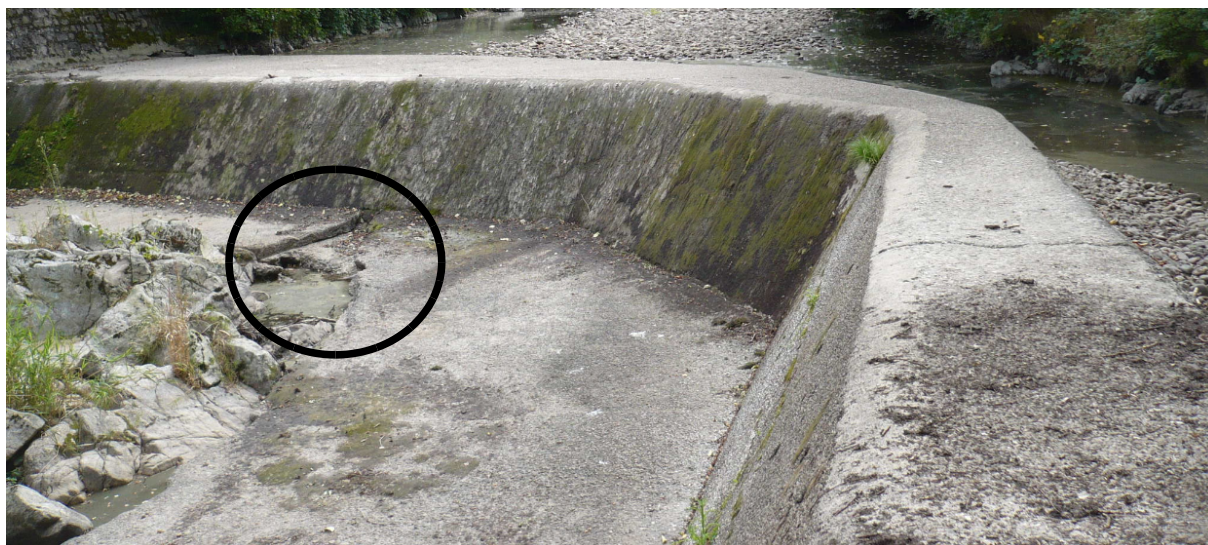
Photo 5 : Etiage septembre 2009 seuil et prise d'eau amont Munas : secs.
