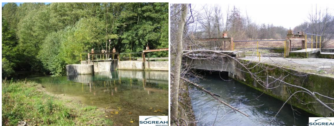
Figure N° 21.. PRISE D'EAU DE L'USINE AHLSTROM (VUE SUR LA GERE DEPUIS L'AMONT ET VUE DE L'ENTREE DU CANAL) (TERRAIN SOGREAH, 07/10/2010)
