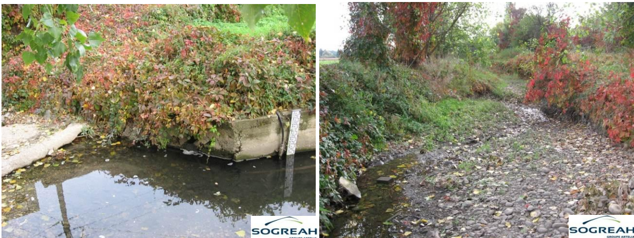
Figure N° 3... VUES DE LA STATION HYDROMETRIQUE DE LA VESONNE A ESTRABLIN (OCTOBRE 2010)
