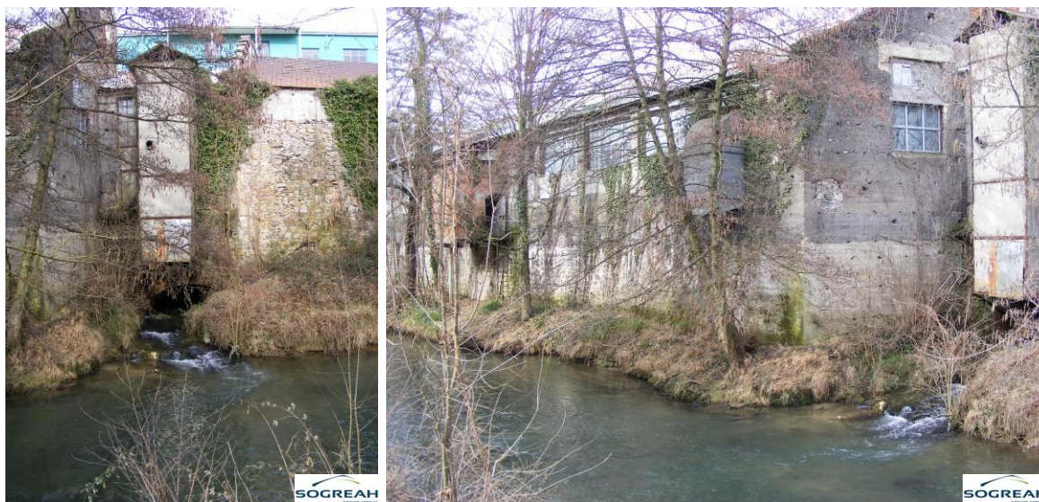
Figure N° 22.. RESTITUTION DE L'USINE AHLSTROM (VUE DE FACE ET VERS L'AVAL) (TERRAIN SOGREAH FEVRIER 2011)
