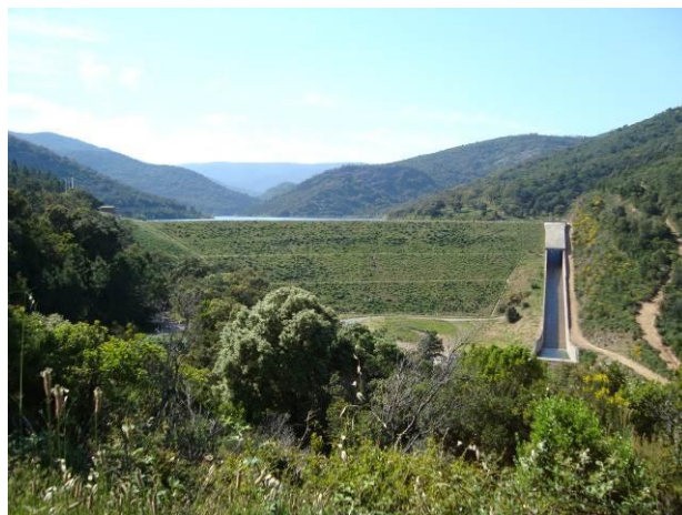
Figure 16 : Vue de la face aval du barrage de la Verne
