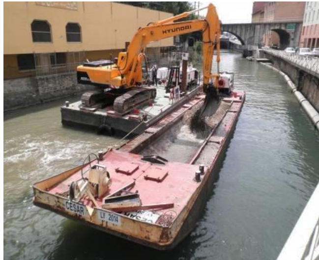
Figure 42 : Illustration d'une pelleteuse sur ponton et d'une barge à clapet à la confluence de la Gère (cf. Mission 4)
