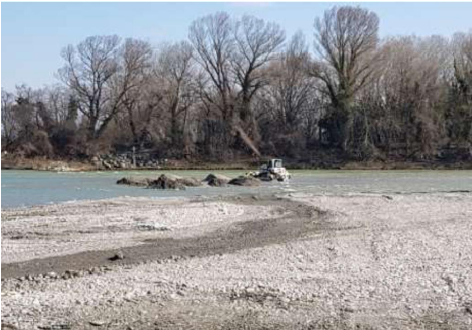
Figure 34 : Recharge en andains et régalinge sous le niveau d'eau pour les matériaux de la lône de la Grange Ecrasée (UHC#19-DZM / RCC de Donzère)
