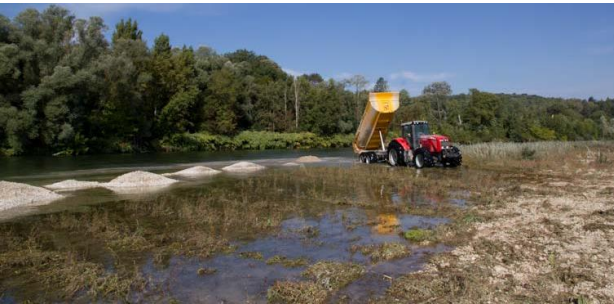
Exemple de mise en andains sur les berges Rivière d'Ain (SR3A, 01) – quelques centaines à quelques milliers de m³
