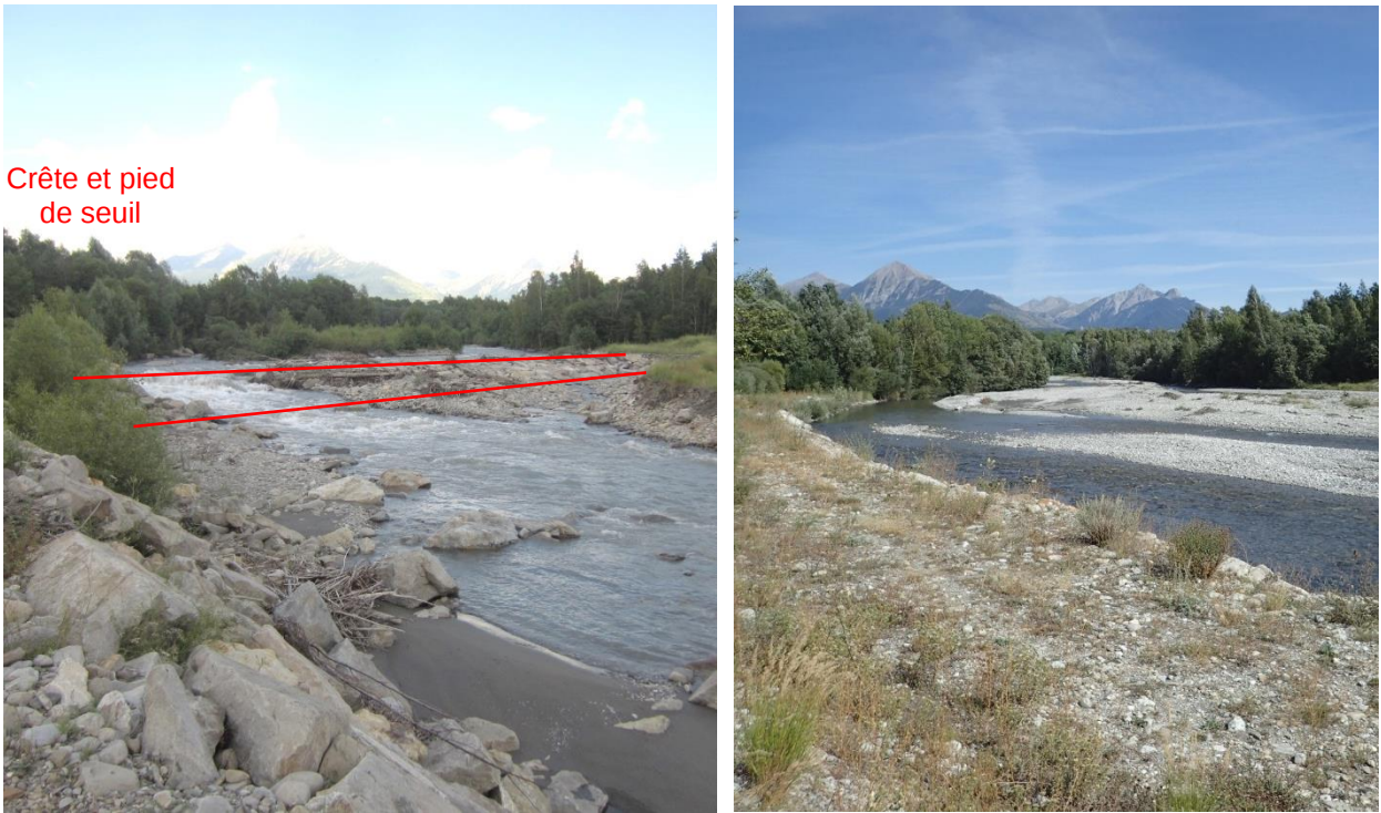
Figure 22 : Recharge sédimentaire et élargissement du lit du Drac en Champsaur ayant permis de noyer dans le lit alluvial le seuil d'alimentation d'un plan d'eau (F.Laval, 2013 ; 2016)
