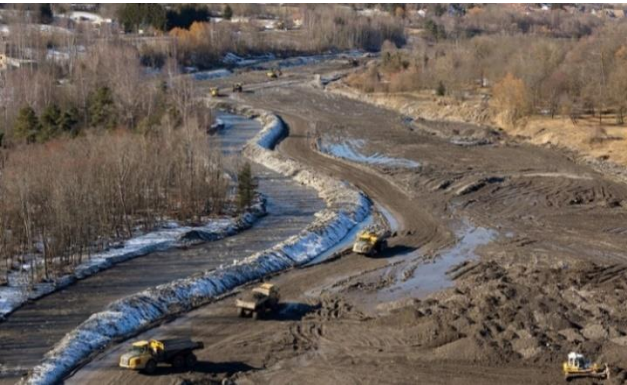
Exemple de reconstitution d'un matelas alluvial Haut-Drac (CLEDA, 05) – 355 000 m³ Photos pendant les travaux, 1 an après travaux, 3 ans après travaux
