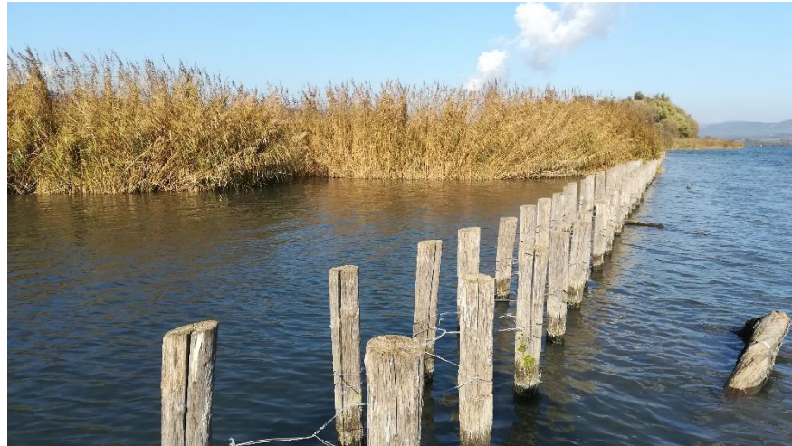
Figure 26 : Exemple de roselière constituée sur des hauts fonds en entrée de canal usinier de Montélimar (ARALEP)
