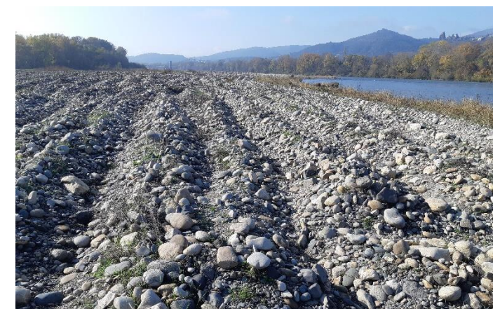
Figure 9 : Engins utilisés et exemple de banc perché charrué (RCC de Montélimar ; ARALEP)
