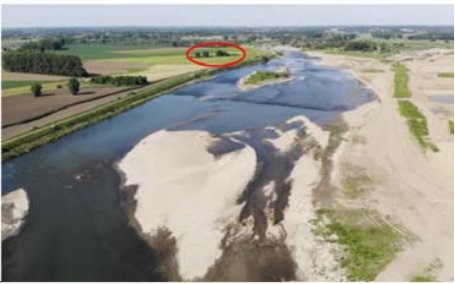
La Meuse dans le secteur de Meers avant/après travaux (Kurstjens & Van Looy, 2020)
