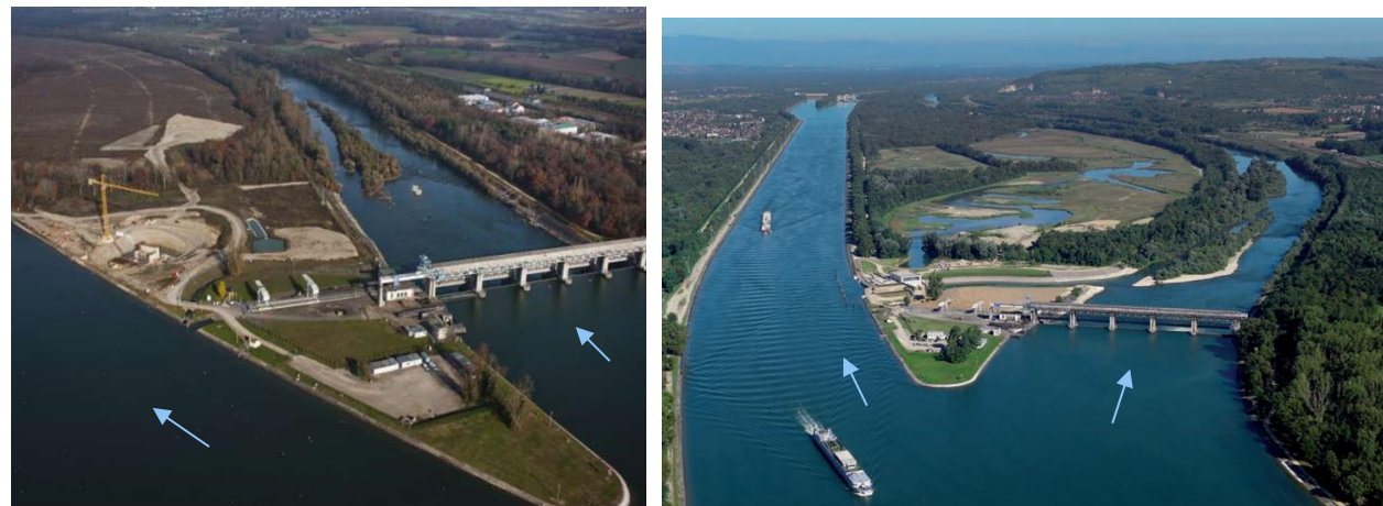
Figure 24 : Aménagement de la centrale K et restauration du Petit Rhin en aval du barrage de Kembs (2015 à gauche et état actuel à droite) (source EDF)
