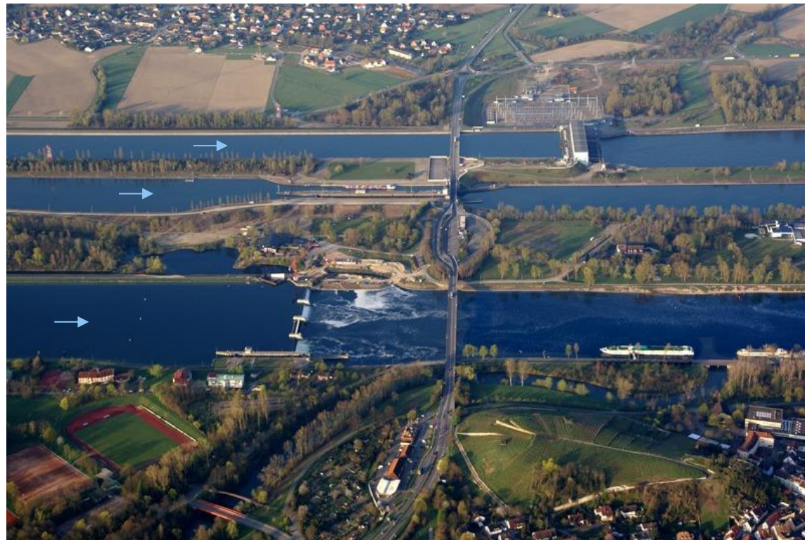
Figure 13 : Le Grand Canal d'Alsace et la centrale-écluse de Vogelgrun sur le Rhin (source Wikipédia)
