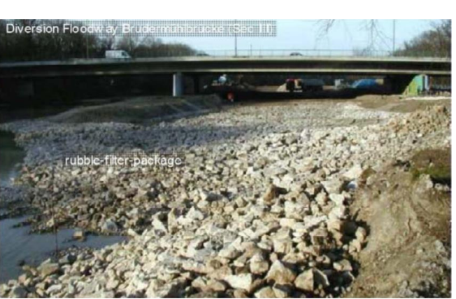
Figure 102 : Travaux de pavage et d'enherbement d'un déversoir en lit moyen (Wulf, 2013)
