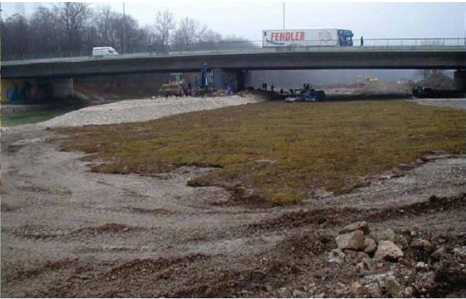
Figure 102 : Travaux de pavage et d'enherbement d'un déversoir en lit moyen (Wulf, 2013)
