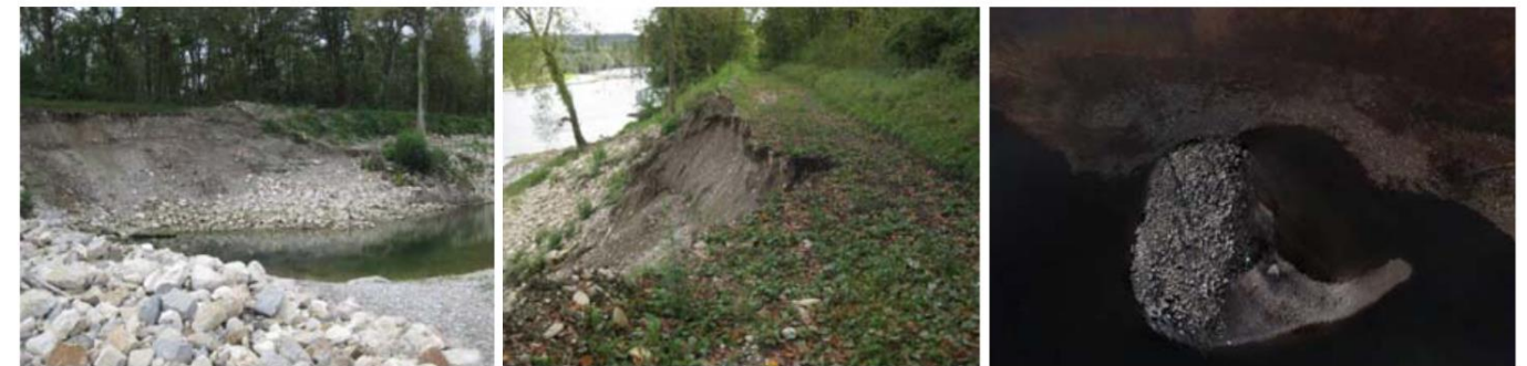
Figure 25 : Encoche d'érosion à l'amont du site et langue de dépôt en aval (Pinte, 2015)
