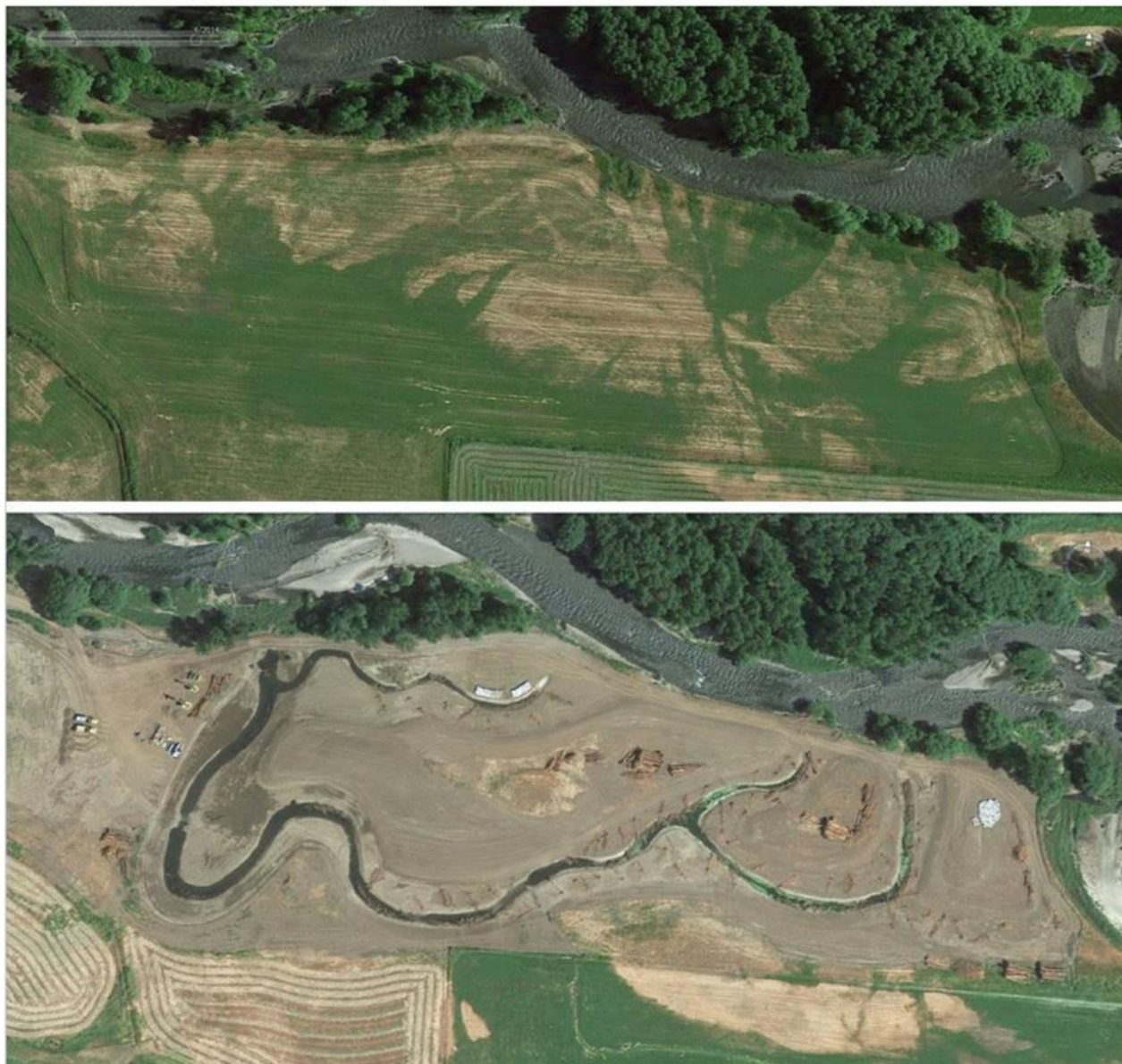
Figure 74 : Exemples d'action de restauration proposées sur des affluents de la Columbia River (BPA, 2020)
