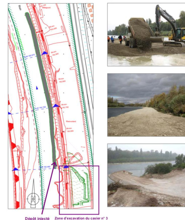
Figure 22 : Extrait du plan de récolement indiquant la position du dépôt injecté (novembre 2010) et vues du chantier (Arnaud, 2012)
