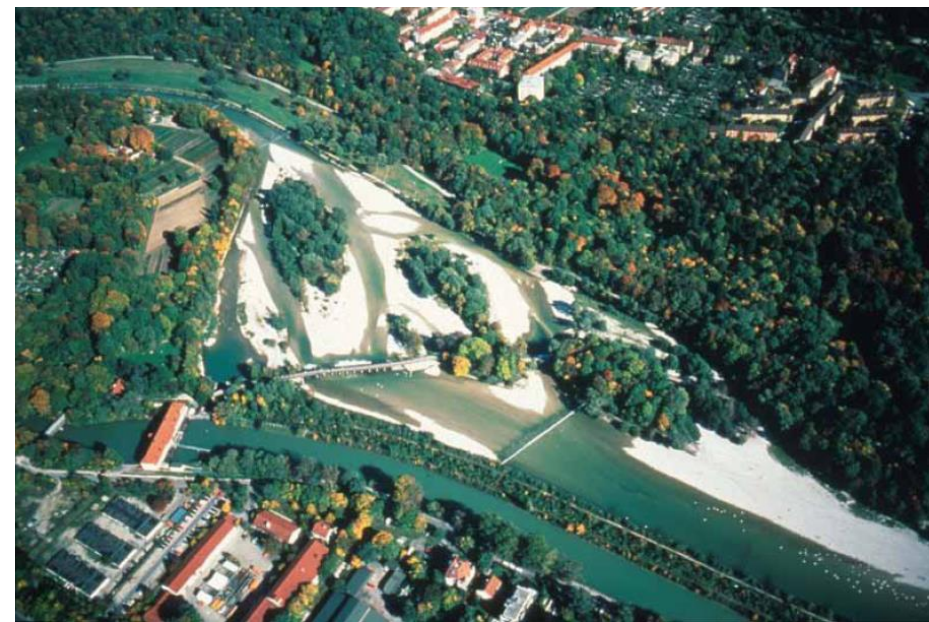
Figure 93 : Secteur de Flaucher pris pour référence avant travaux de restauration (Wulf, 2013)
