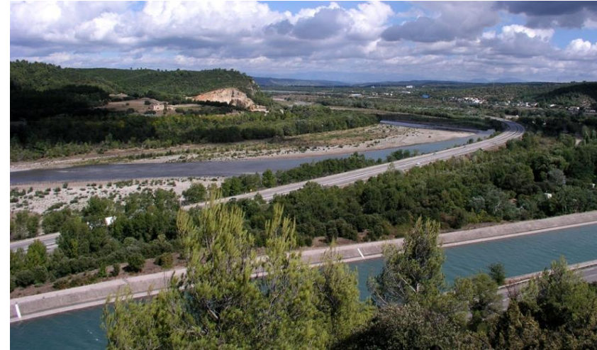
Figure 76 : Aménagement hydroélectrique de la Durance (SMAVD, 2020)
