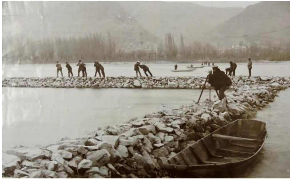
Figure 21 : Construction des casiers dits « Girardon » (in ACTHYS, 2017)
