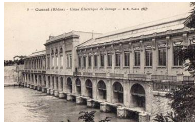
Figure 28 : Les premiers aménagements hydroélectriques du Rhône : la Centrale Hydraulique de la jonction de la Valserine, le Pont de la Machine (début 20 ème siècle) et l'usine de Cusset (début 20 ème siècle) (source : en haut à gauche, Archive Départementale de l'Ain ; en haut à droite collection BGE, Centre d'iconographie genevoise ; en bas : http://industrialheritage.eu )
