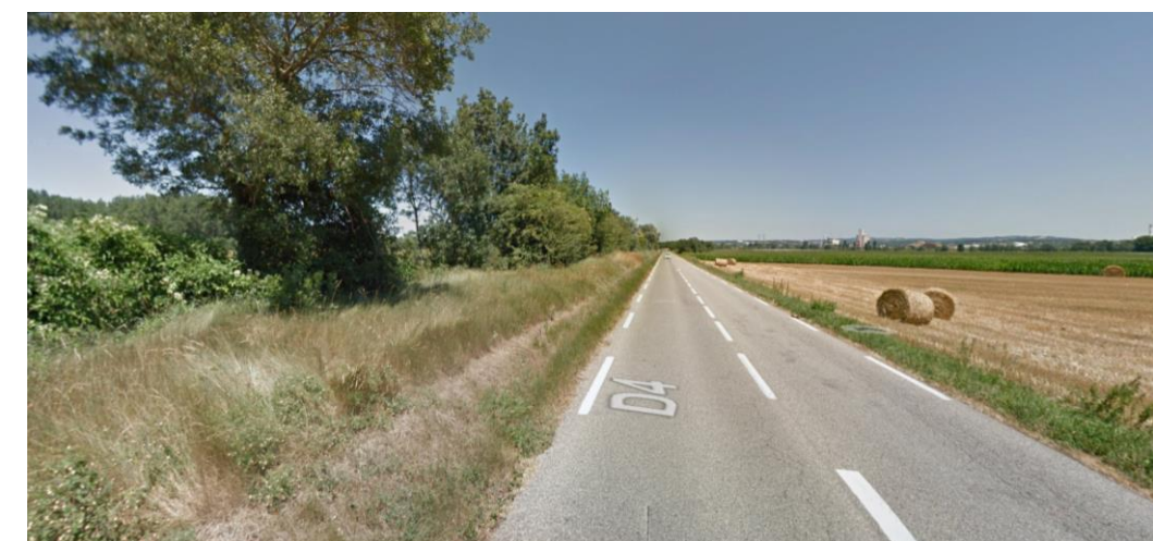
Figure 18 : Ancienne digue paysanne dans la plaine de Péage de Roussillon (13-PDR) qui supporte aujourd'hui la RD4 entre Sablons et Salaise (Google)
