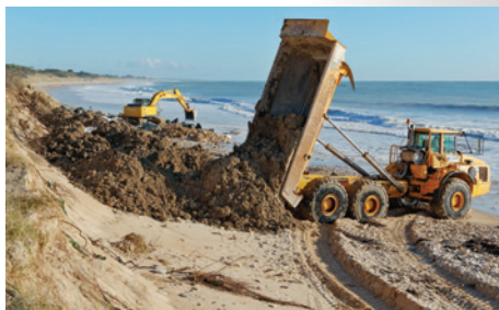
Rechargement d'un cordon dunaire
