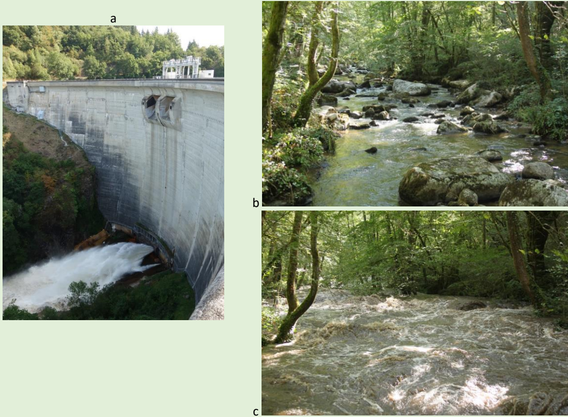
Figure 96 : a) exemple de l'un des lâchers au barrage de Maury sur la Selves et vues du cours d'eau b) au débit réservé (0.24 m 3 /s) et c) au moment du lâcher à 20 m 3 /s. © R. Loire (EDF)
