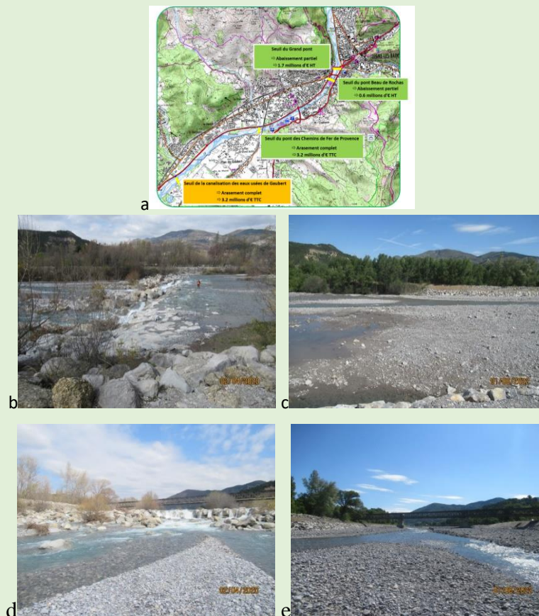
Figure 86 : a) vue générale des travaux. NB : le seuil de Gaubert n'a pas encore été effacé. c) à e) vues du seuil du pont du chemin de fer avant et après dérasement.
