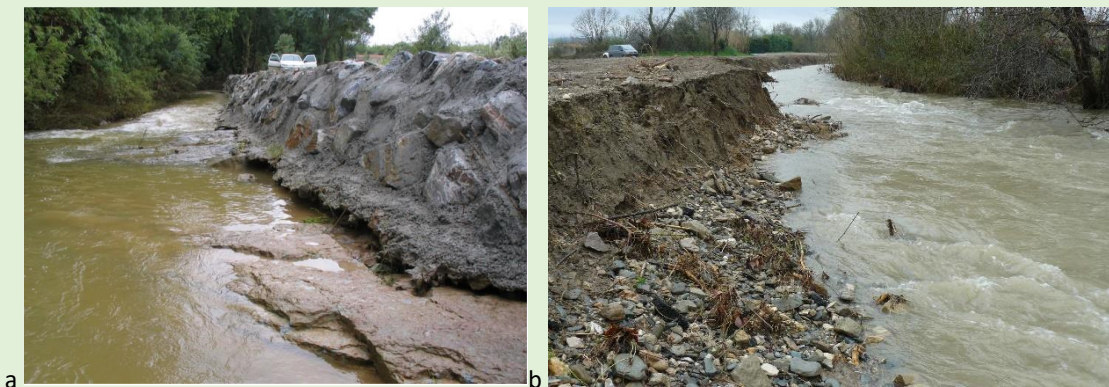
Figure 77 : a) La Clamoux le long de la RD 37 avant travaux. Corsetage, incision, réparation enrochements après chaque crue, b) premières érosions après le désenrochement (printemps 2022)
