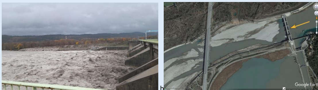
Figure 87 : a) le barrage de Cadarache en transparence. b) les bancs alluviaux liés au transit des matériaux grossiers au travers de l'ouvrage
