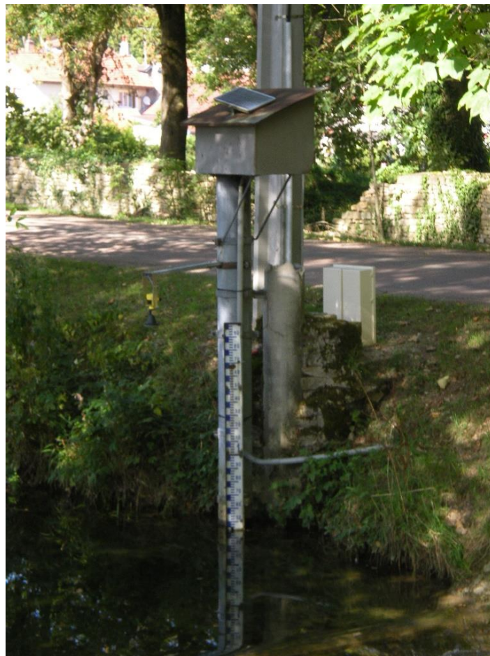
FIGURE 2: STATION HYDROMETRIQUE SUR LA VENELLE A SELONGEY
