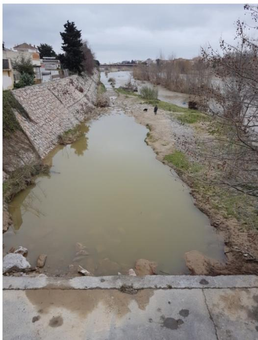
*Photo 19 : Erosion de la berge basse de la digue Vernet-Est*
