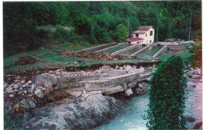
*Photo 08 : La pisciculture de Sahorre ravagée par la Rotja. Les bassins et le laboratoire ont été submergés par une vague de 4 à 5 m poussant devant elle un barrage de bois et de pierre*
