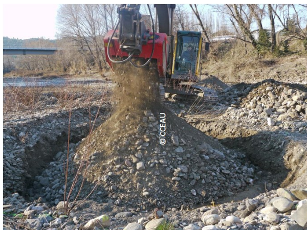
concassage avec un godet concasseur (d'autres outils sont possibles) (photos © CCEAU)
