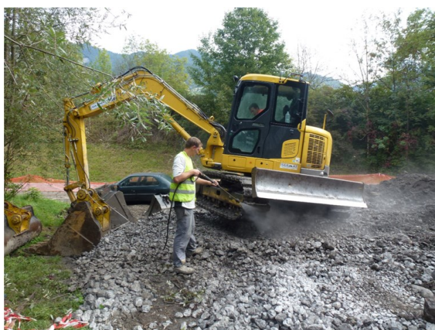
nettoyage soigneux des engins de terrassement avant qu'ils ne quittent le chantier (photos © CCEAU)
