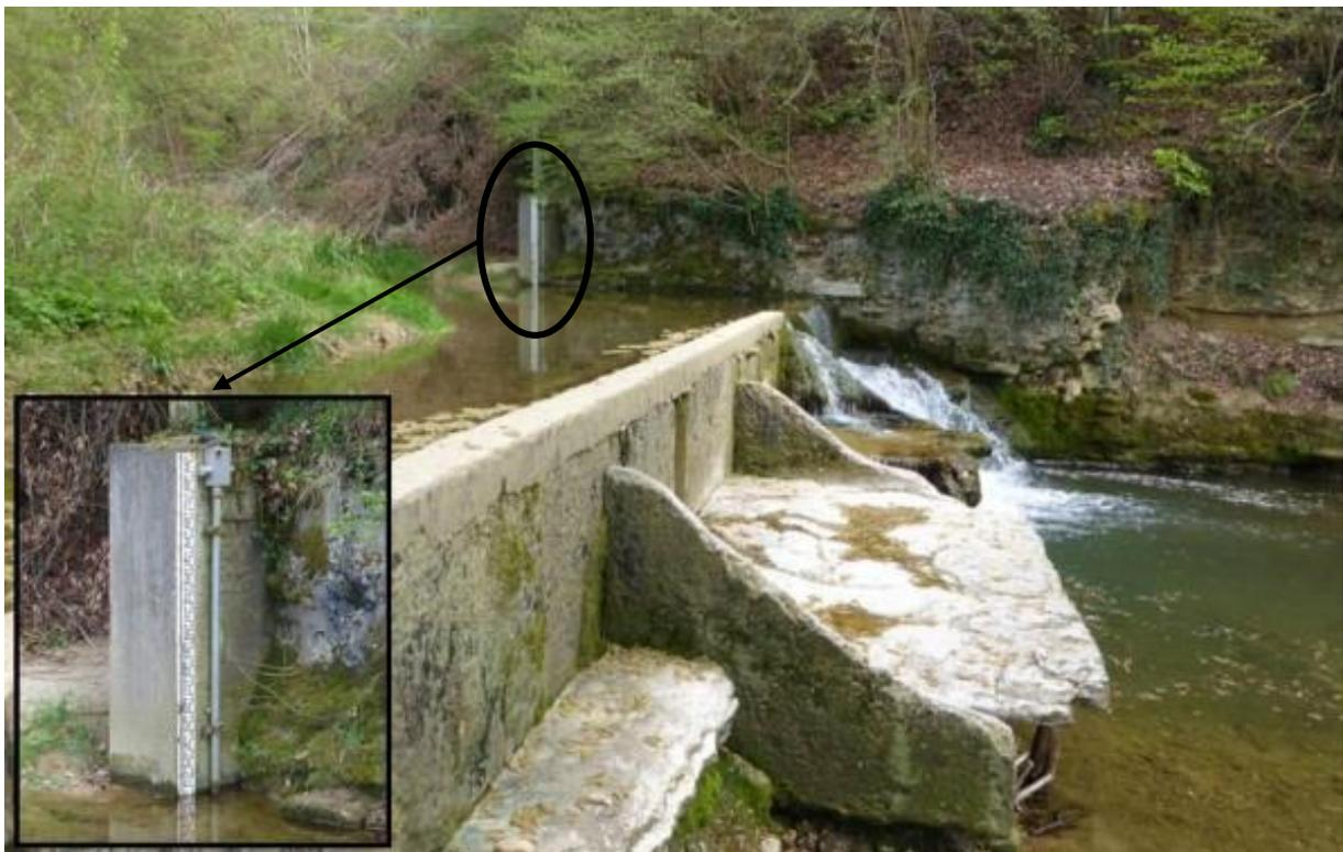
Figure 16 : Photographie de l'échelle limnimétrique de la station (Source : PPRi Sanne DDT38)
