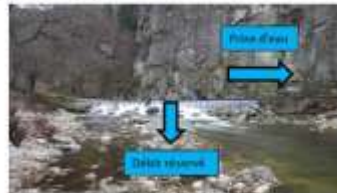
Prise d'eau d'une béalière sur le Doux
