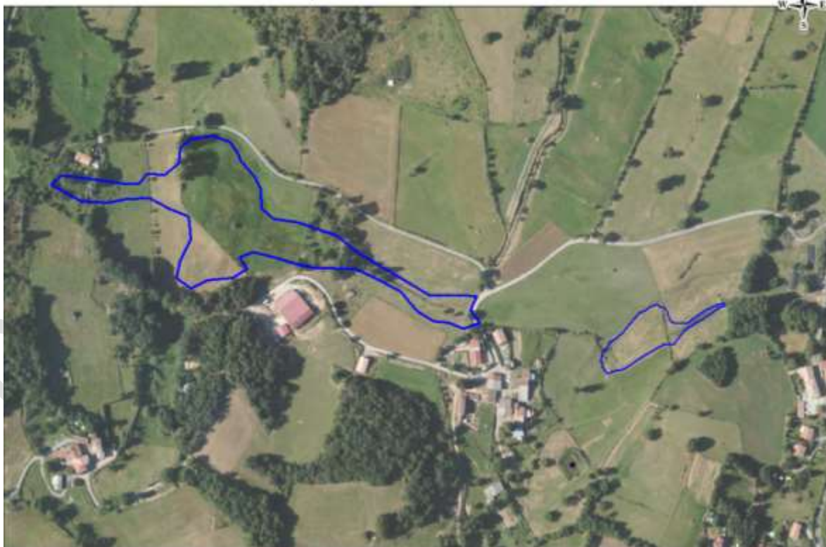
Délimitation de la zone humide de la Bâtie de Crussol, vue aérienne
