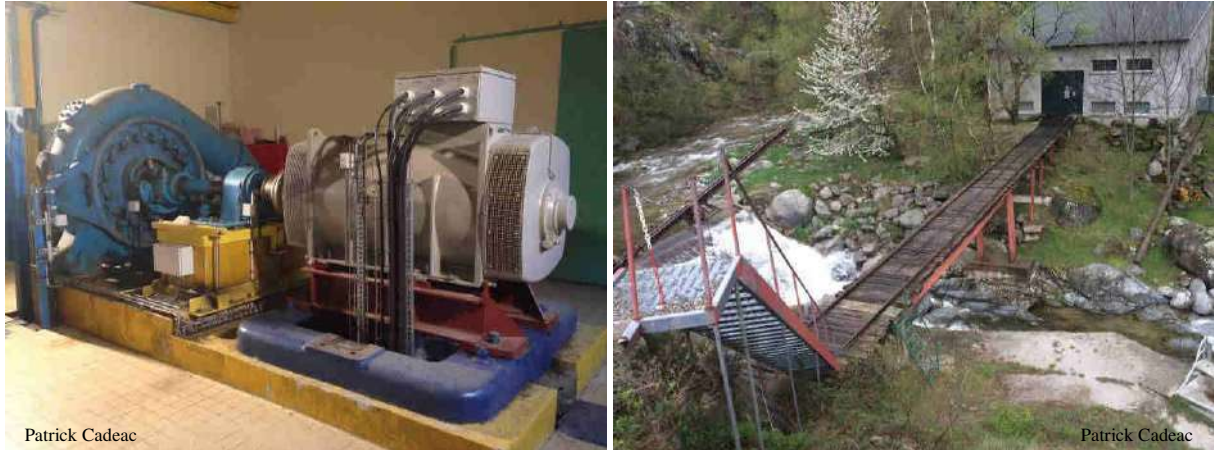
Turbine et génératrice de 350 Kw et vue de l'usine de Sahorre Thorrent
