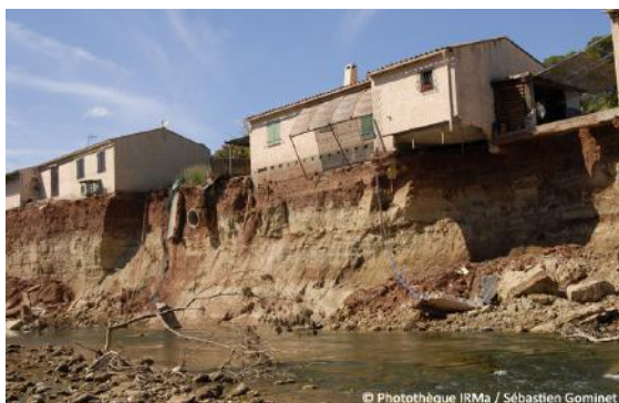
Figure 30 : Dégâts engendrés par l'épisode du 15 juin 2010 sur la Commune de La Motte (source: IRMa, SG)
