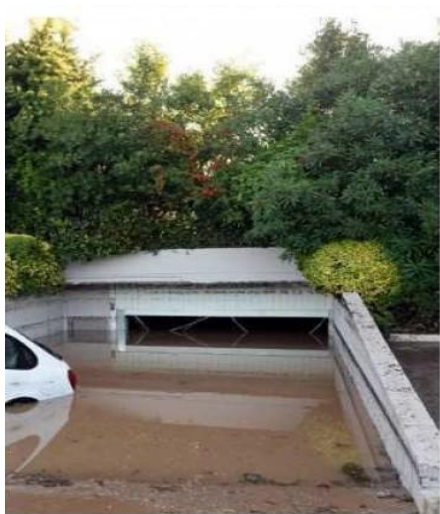
Figure 39: Inondation d'un parking souterrain (source: Préfecture 06)
