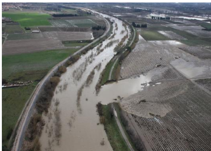
Figure 22 : Brèche dans la digue de l'Agly à Pia lors de la crue de mars 2013 (source: DDTM66)
