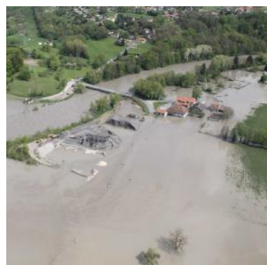
Figure 19 : Débordement de l'Arve sur la commune d'Arthaz – basse vallée au niveau du Pont Neuf (source: SM3A)
