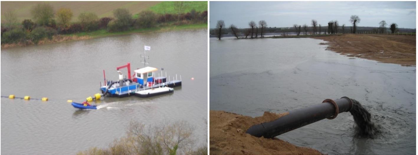
Figure 31 - Dragage de l'étang de Jugon les Lacs (450 000 m<sup>3</sup> – IDRA 2007-2008)
