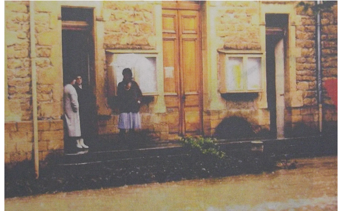
Figure 4 : La crue du 17 mai 1983 de l'Azergues à Chatillon. L'eau atteint la première marche de la mairie (source : PPRI de la vallée de l'Azergues - DDE Rhône – 2008)
