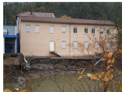
Figure 7 : L'Azergues à l'Arbresle après la crue de novembre 2008 (source : DREAL Lyon)
