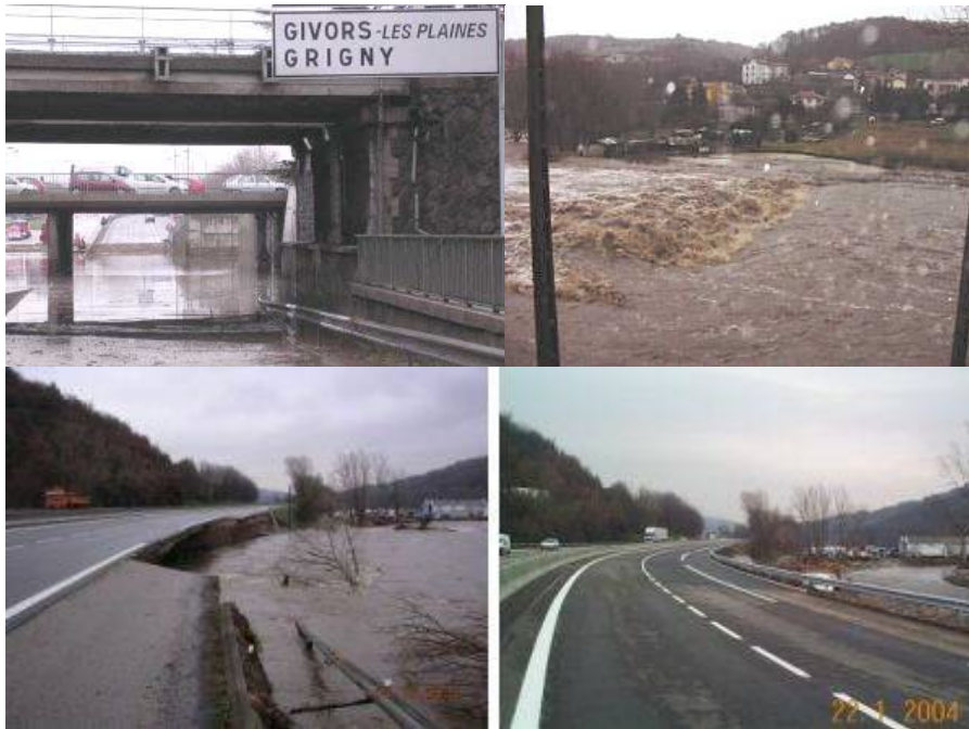
Figure 5: Crue du Gier en 2003 – Secteur de Givors avec dégâts à l'A 47 (source : http://www.hyronnelle.net )
