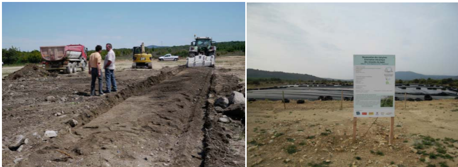
Figure 47 : concassage et bâchage des terres infestées sur une plateforme (© Concept.Cours.d'EAU.)
