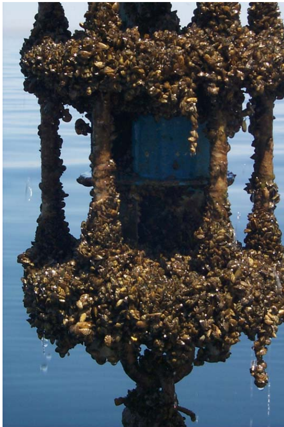
Figure 77 : exemple d'accumulations de moules zébrées sur une structure immergée (source : wikipédia)
