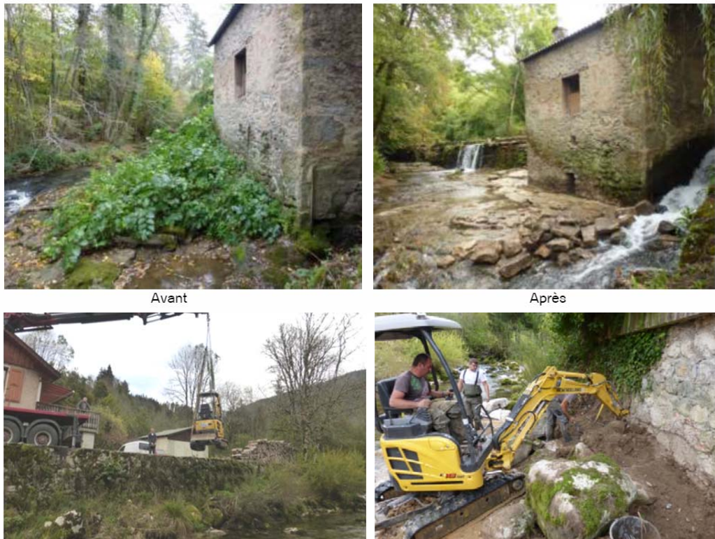
Figure 52 : purge manuelle assistée mécaniquement des renouées asiatiques le long de bâtis anciens
