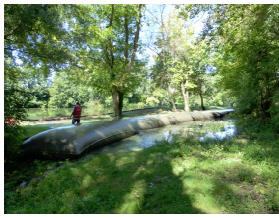
Figure 58 : dispositif breveté de récolte des produits d'hydrocurage
