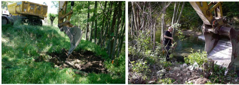
Figure 46 : purge des terres infestées par des renouées du Japon (© Concept.Cours.d'EAU.)
