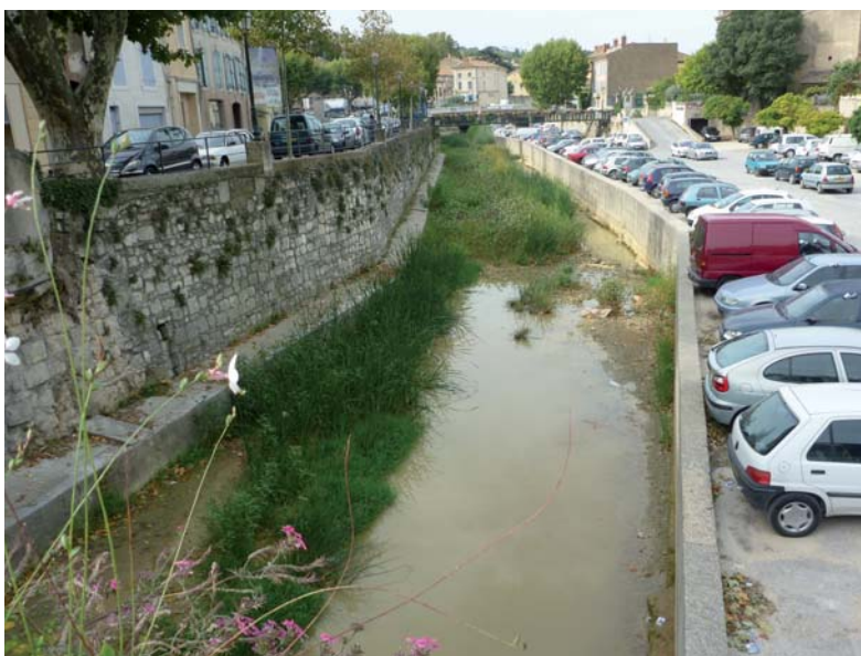
Le Calavon à Apt : lit et berges artificialisés
