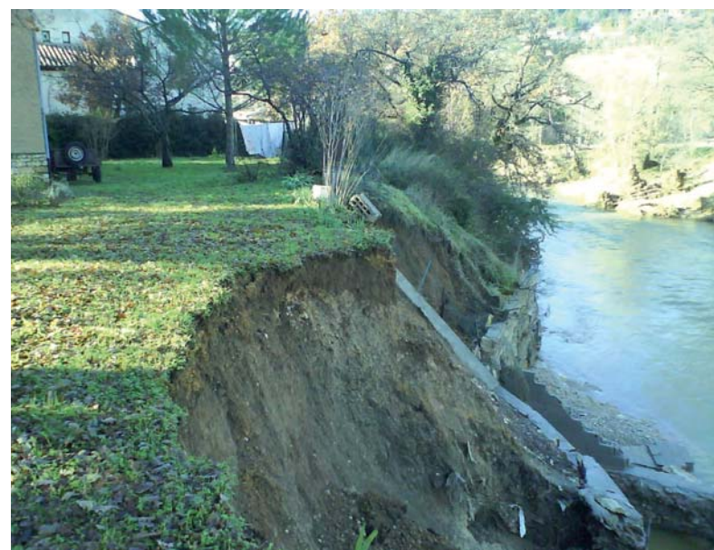
Érosion de berges chez un riverain du Calavon
