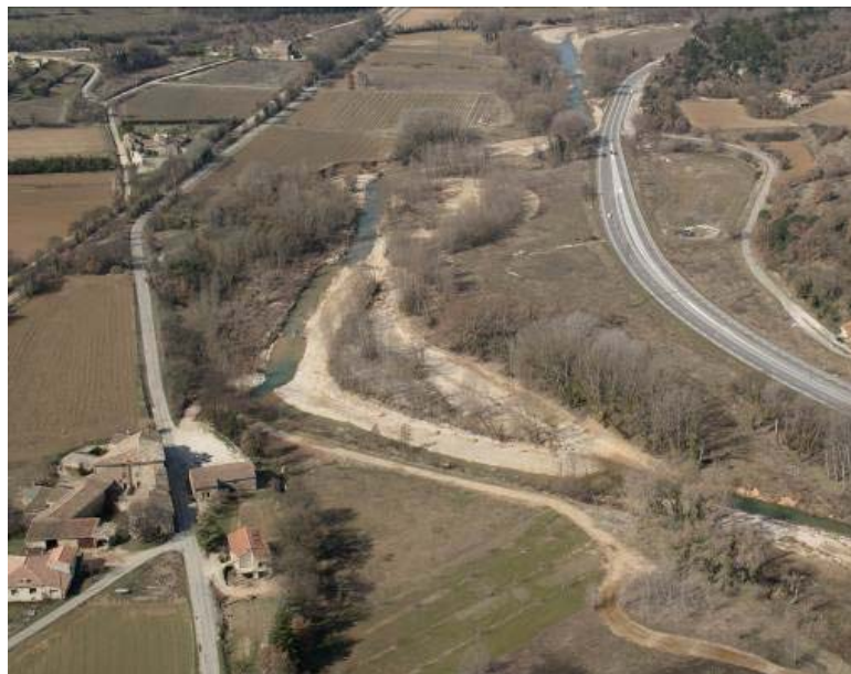
Le Calavon à la Bégude de Goult en mars 2010 : confortement de berges et réouverture d'un ancien lit pour faciliter les écoulements
