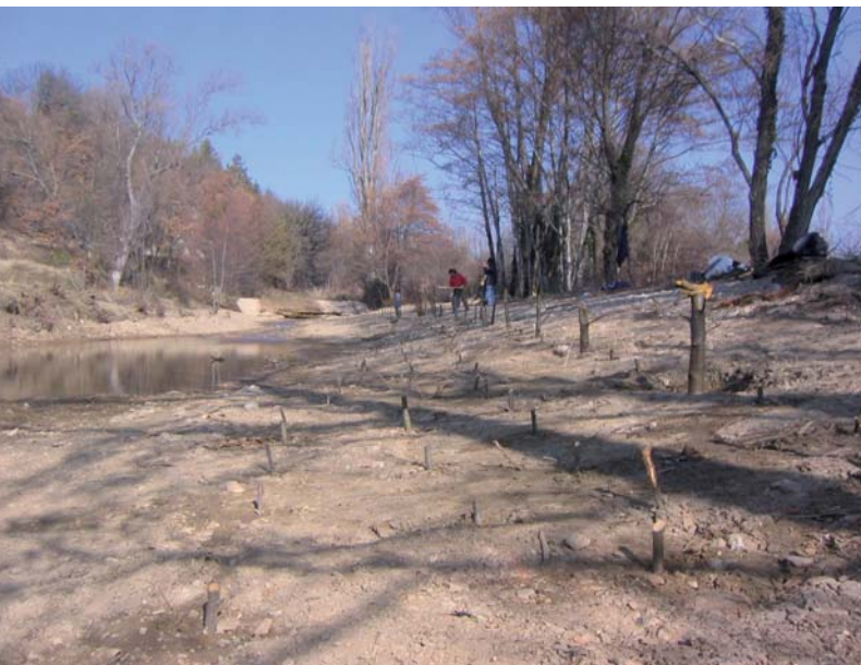
Retalutage de berges et plantations à Châteauvert à Viens en février 2008
