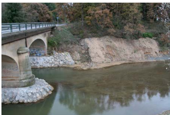
Enfoncement du lit et déstabilisation en pied d'ouvrage
