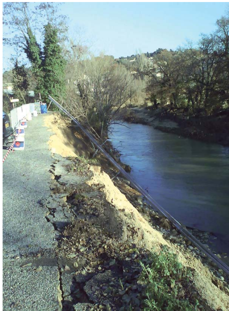
Érosion de berges à proximité d'un parking
