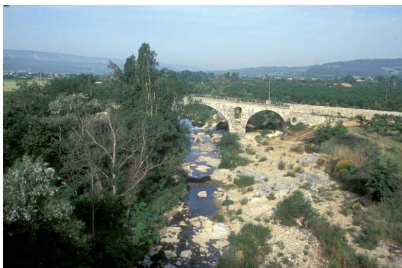
Pont Julien à Bonnieux
