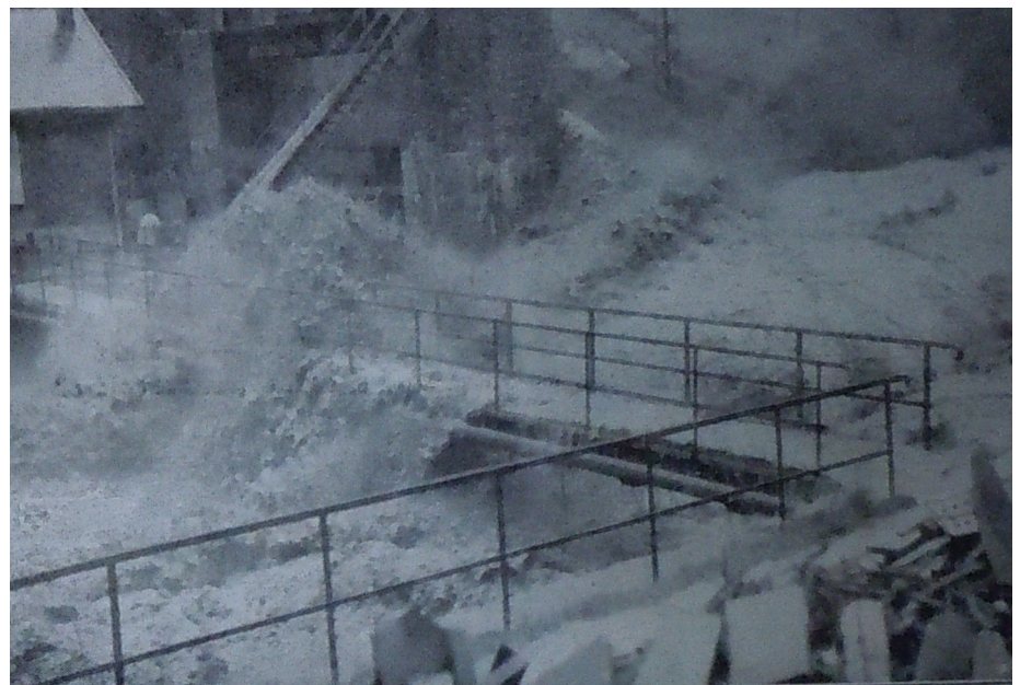
Figure 4 : la Romanche à l'usine des Roberts le 15 septembre 1940 (source : Pardé, 1941)
